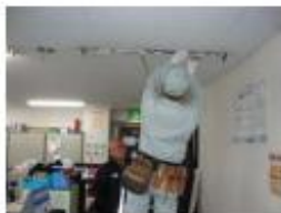
CO 2 削減ポテンシャル診断 事業 (平成 29 年度) *LED 更新工事指導
